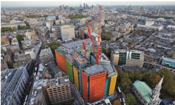
完成間近の様子
