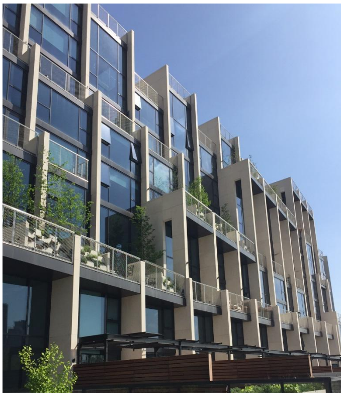
(自然の木肌を生かしたファサード)
