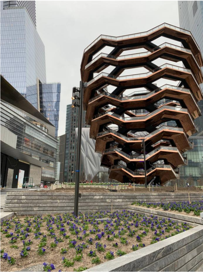
Vessel は連日訪れる人で込み合っている
