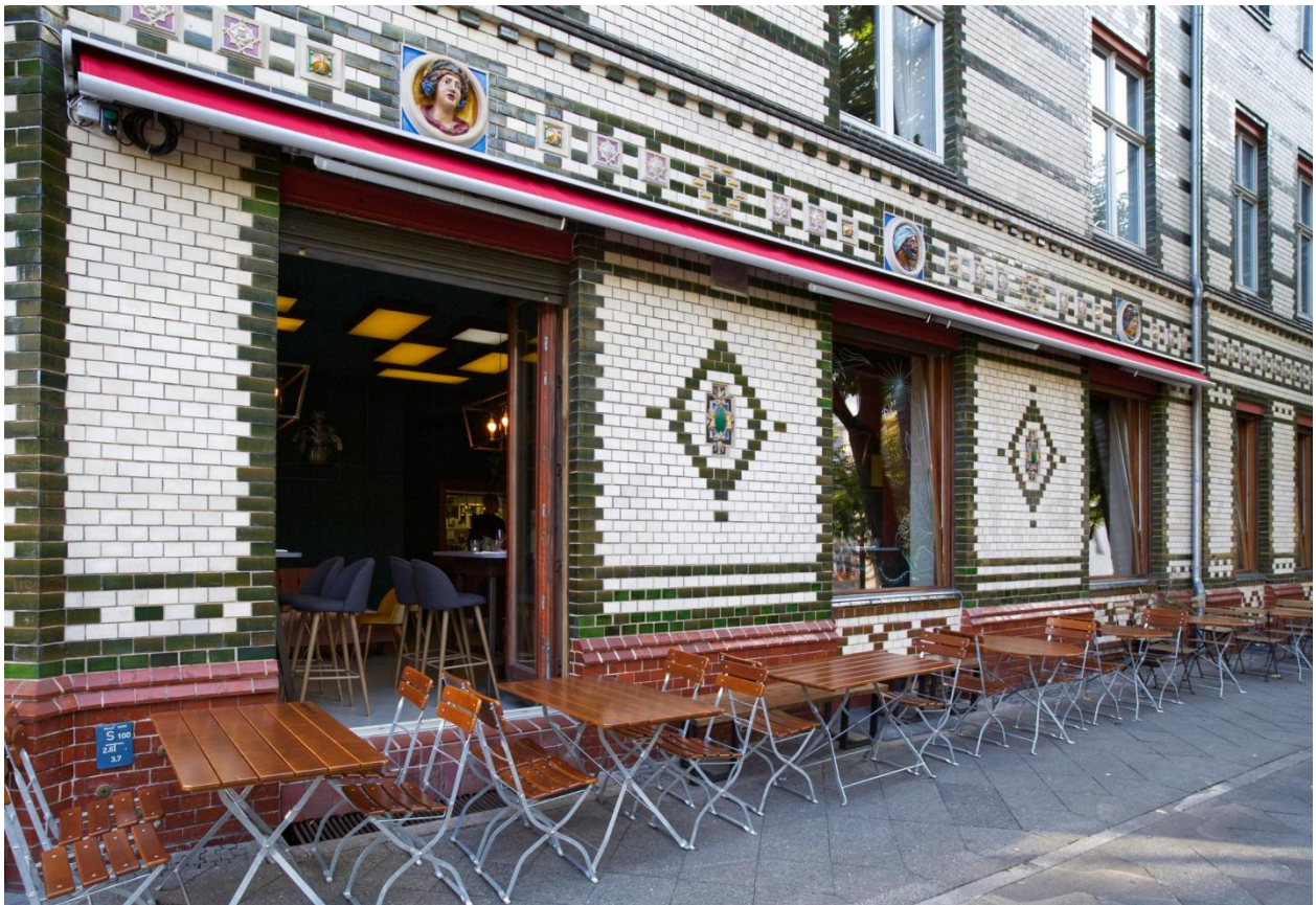
19 世紀に建てられたモザイクタイルが印象的な建物
