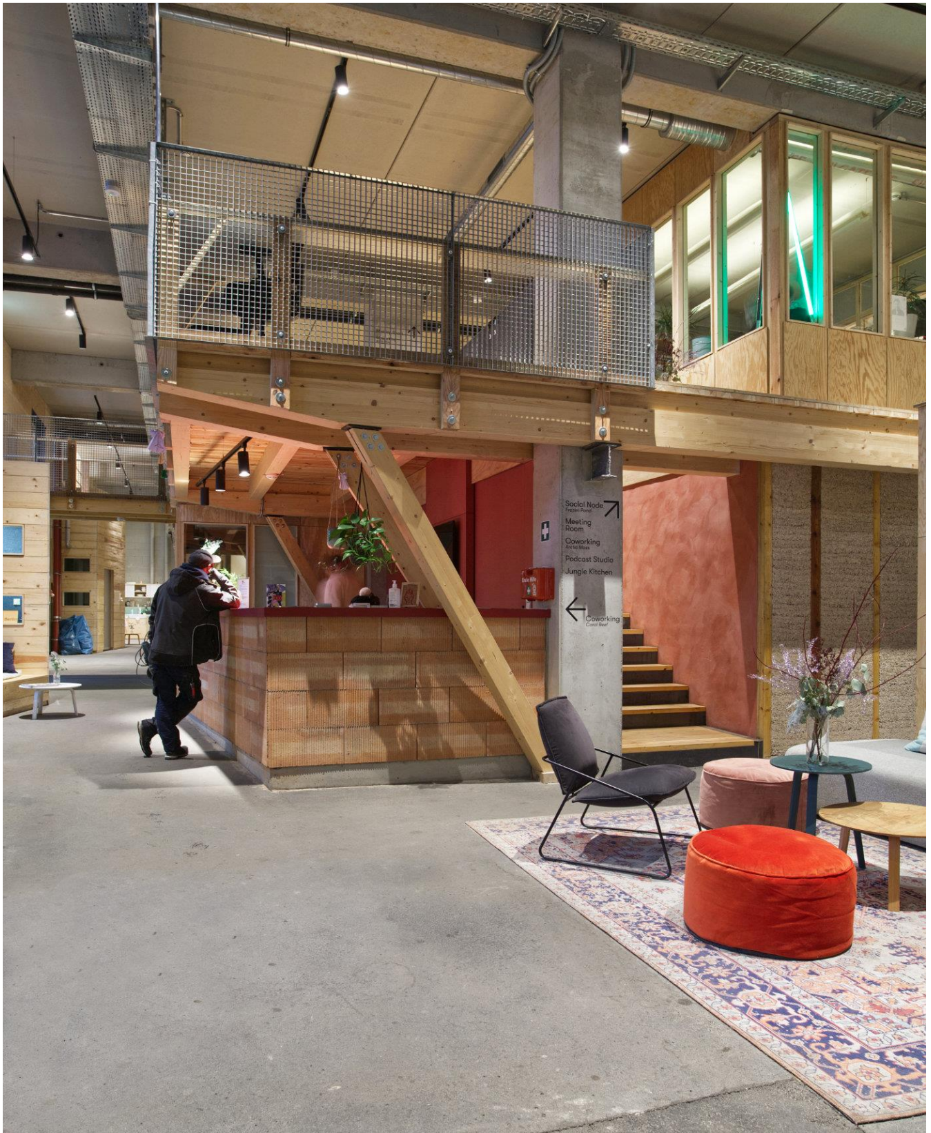
上：煉瓦を積んで作ったレセプション。梁や木繊維の断熱材もあえて剥き出しに。上階のスタッフルームは仕切られているが窓は透明。
